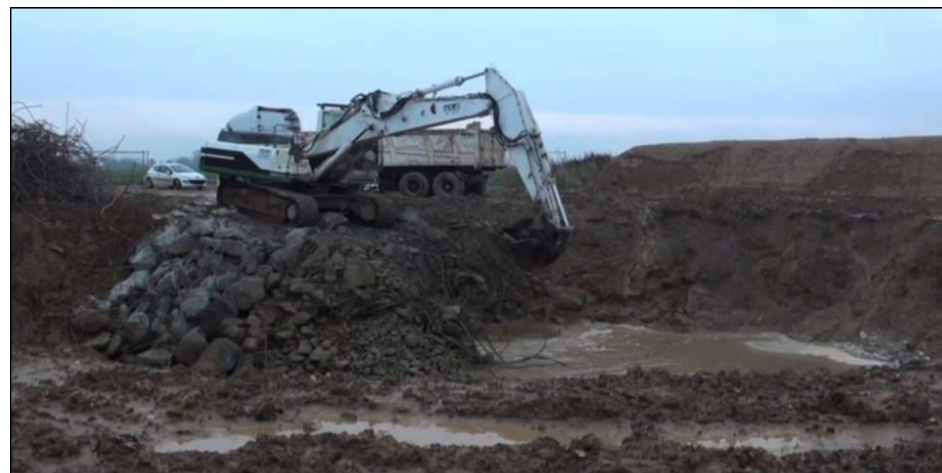
Photo 12: Evacuation des débris
