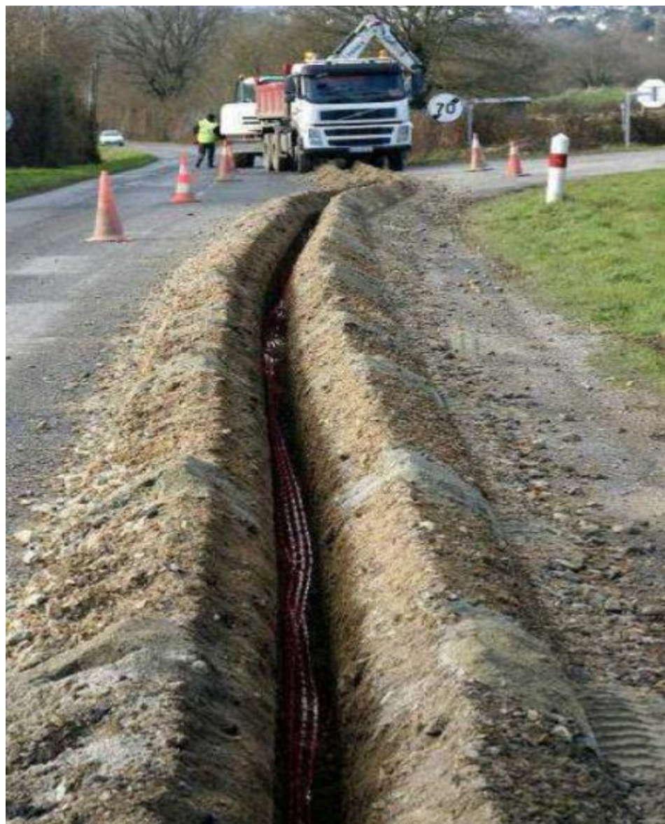
Photo 20: Réalisation d'une tranchée en domaine public
