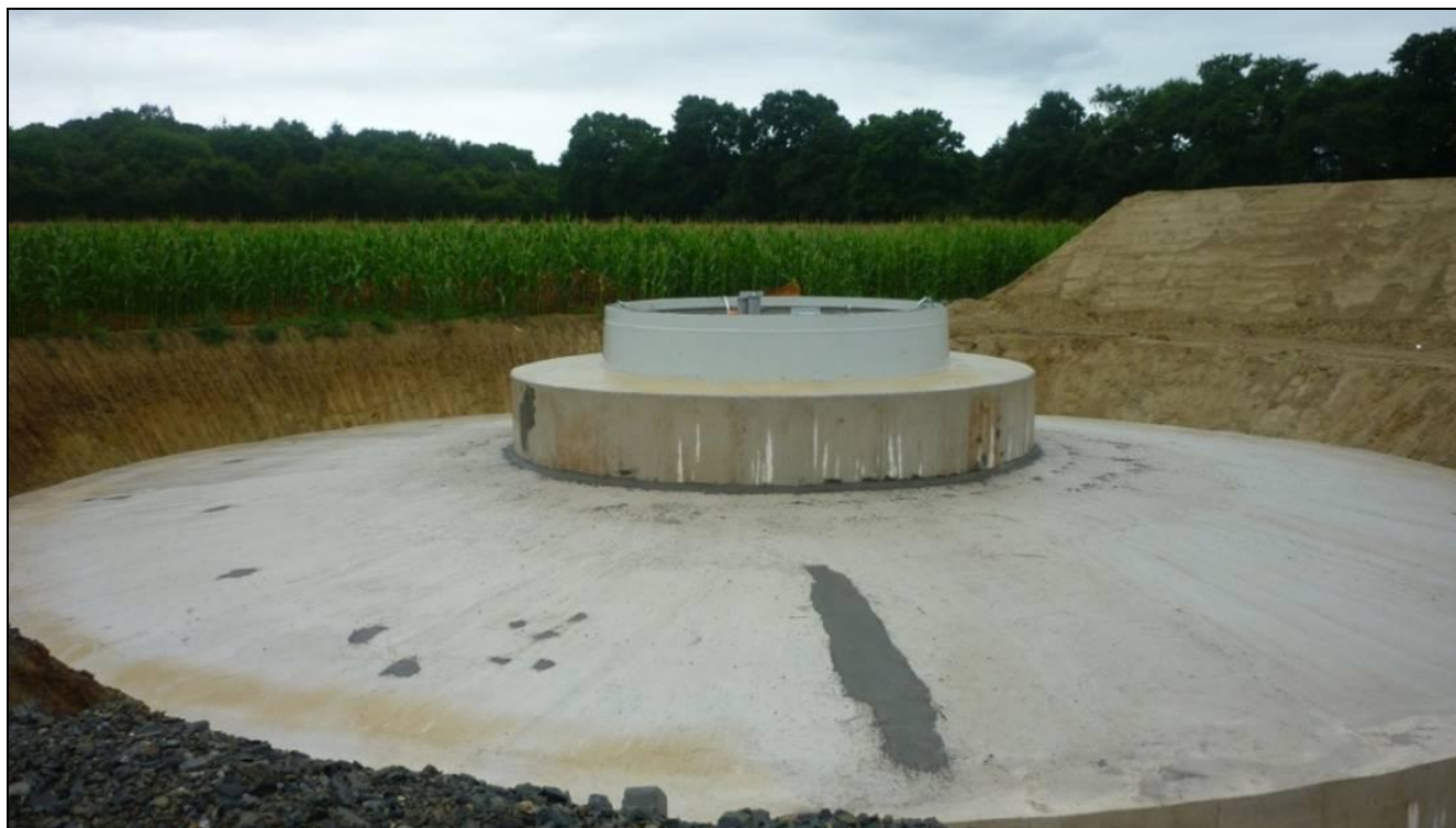
Photo 9 : Etape de bétonnage
