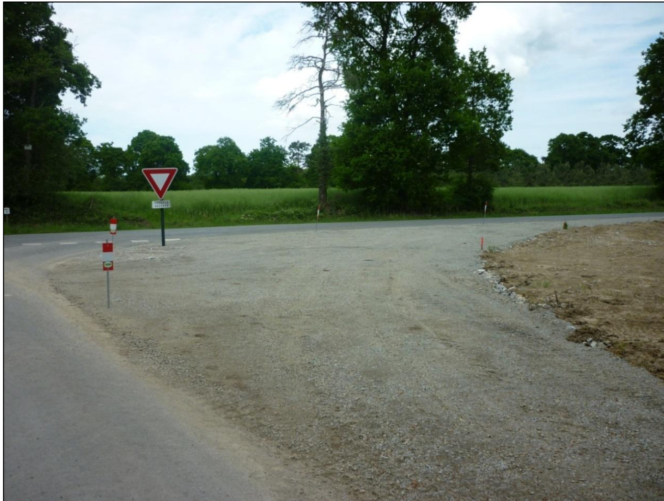
Photo 5: Exemple d'aménagement pendant le chantier
