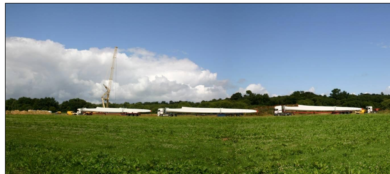
Photo 4 : Arrivée des pales sur site
