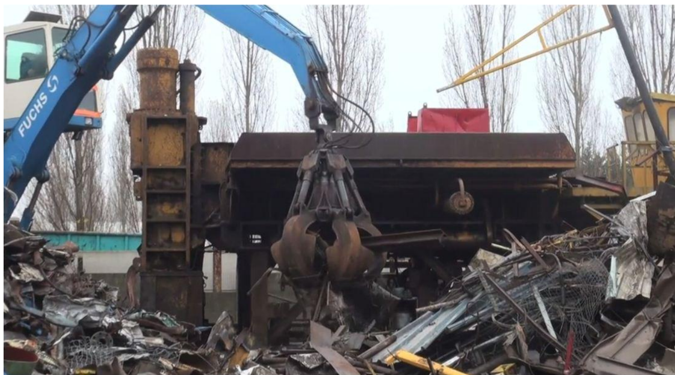
Photo 16: Evacuation des éléments démantelés (2)
