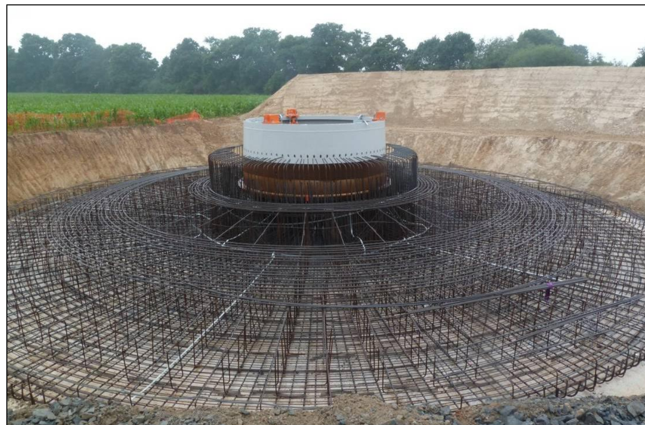
Photo 8 : Etape de Ferrailage
