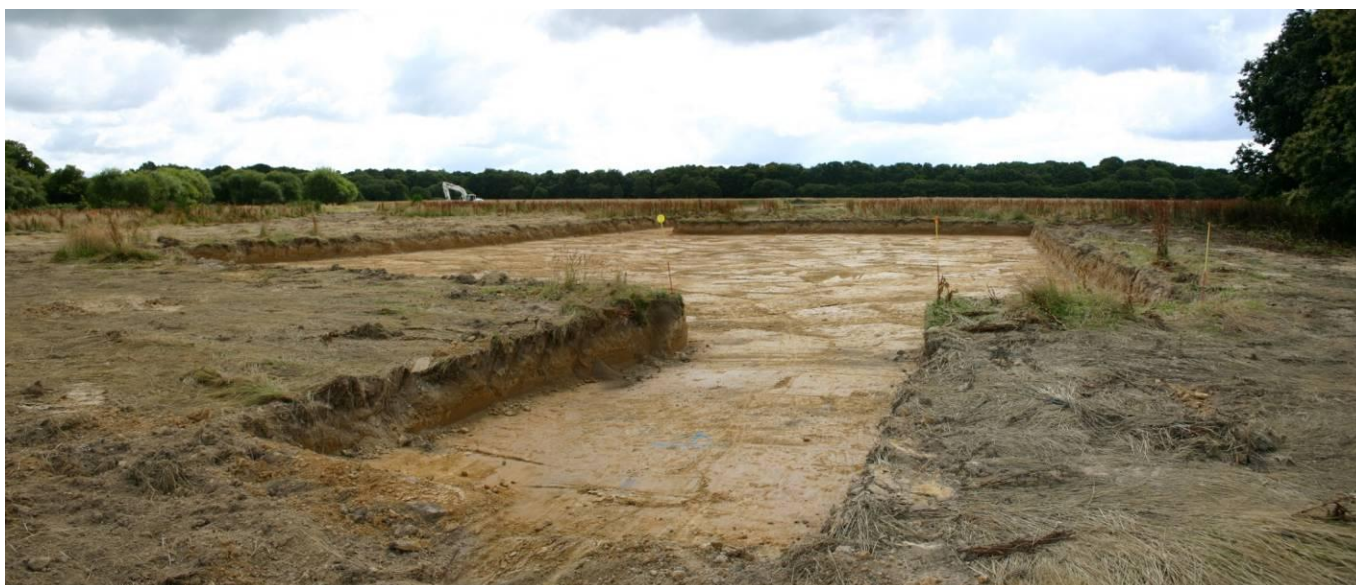
Photo 17 : Exemple de création de plateforme
