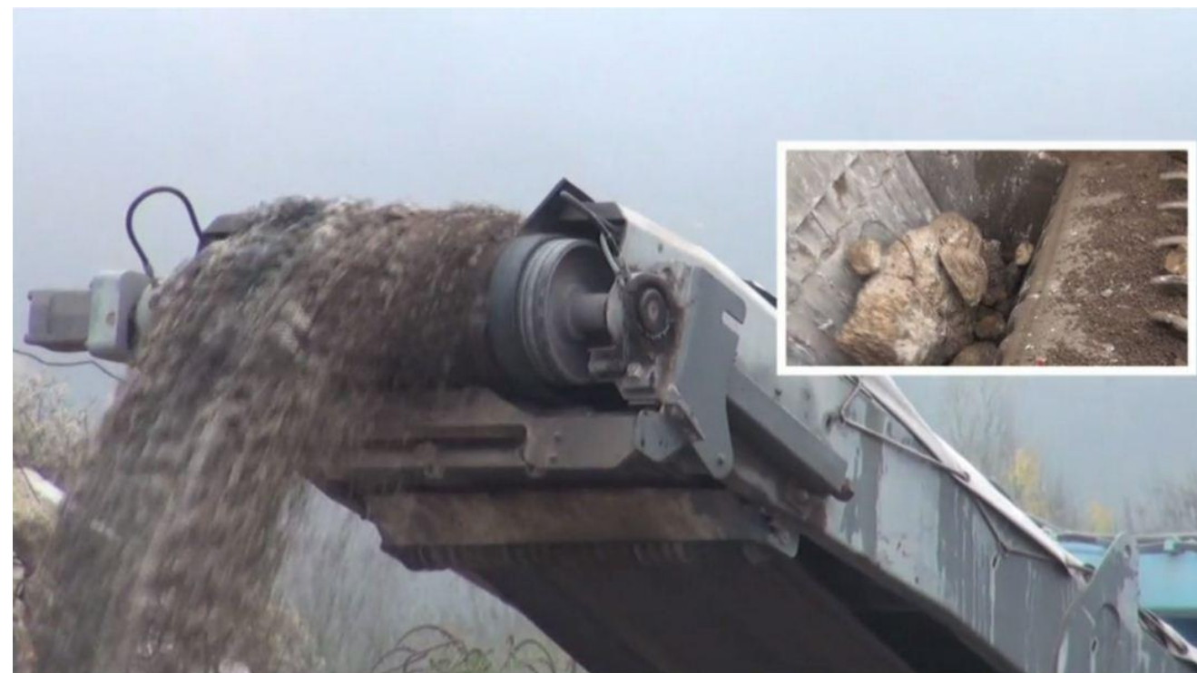
Photo 14: Concassage du béton des fondations
