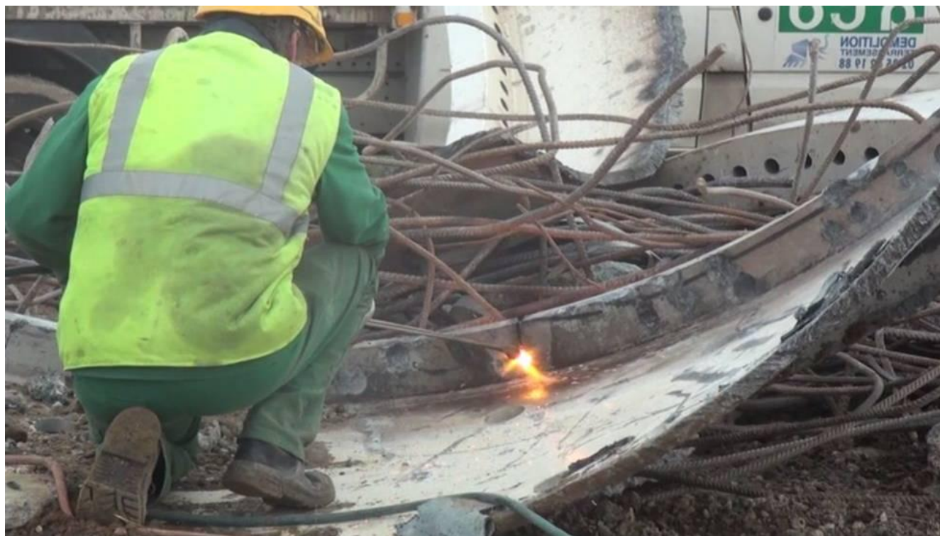
Photo 13 : Tri et découpage au chalumeau d'acier
