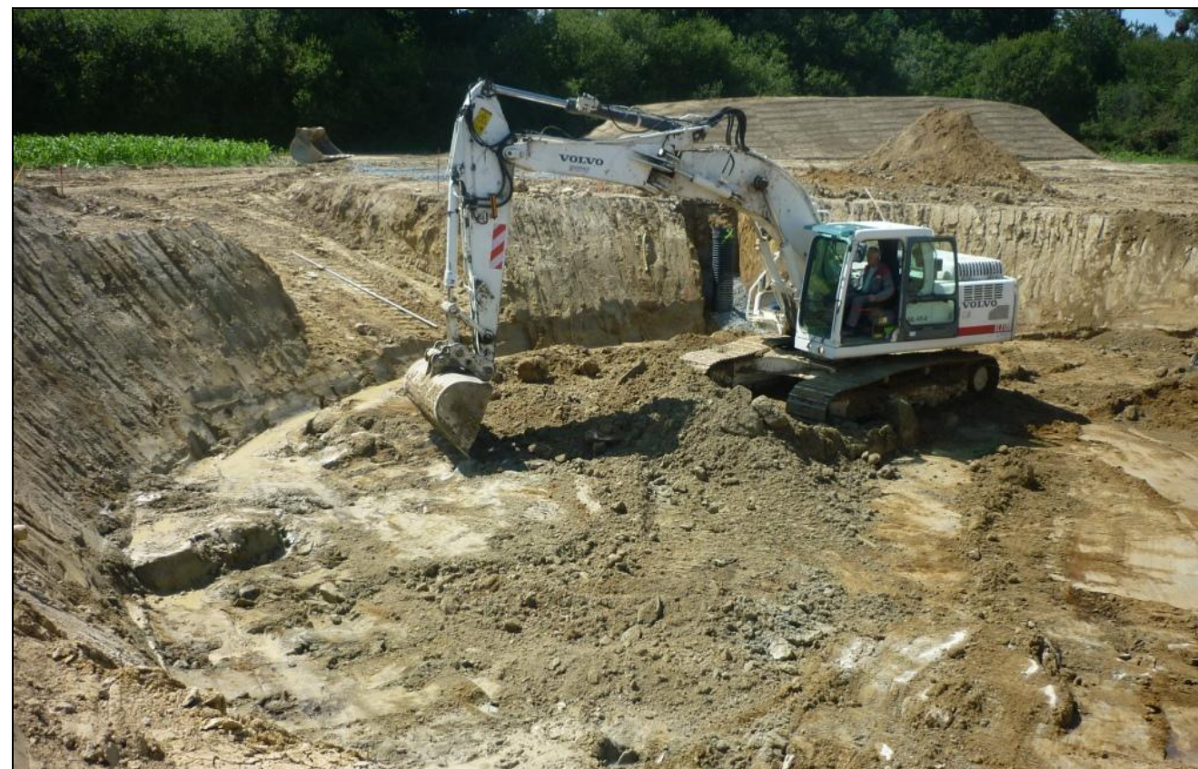
Photo 7 : Excavation de la terre
