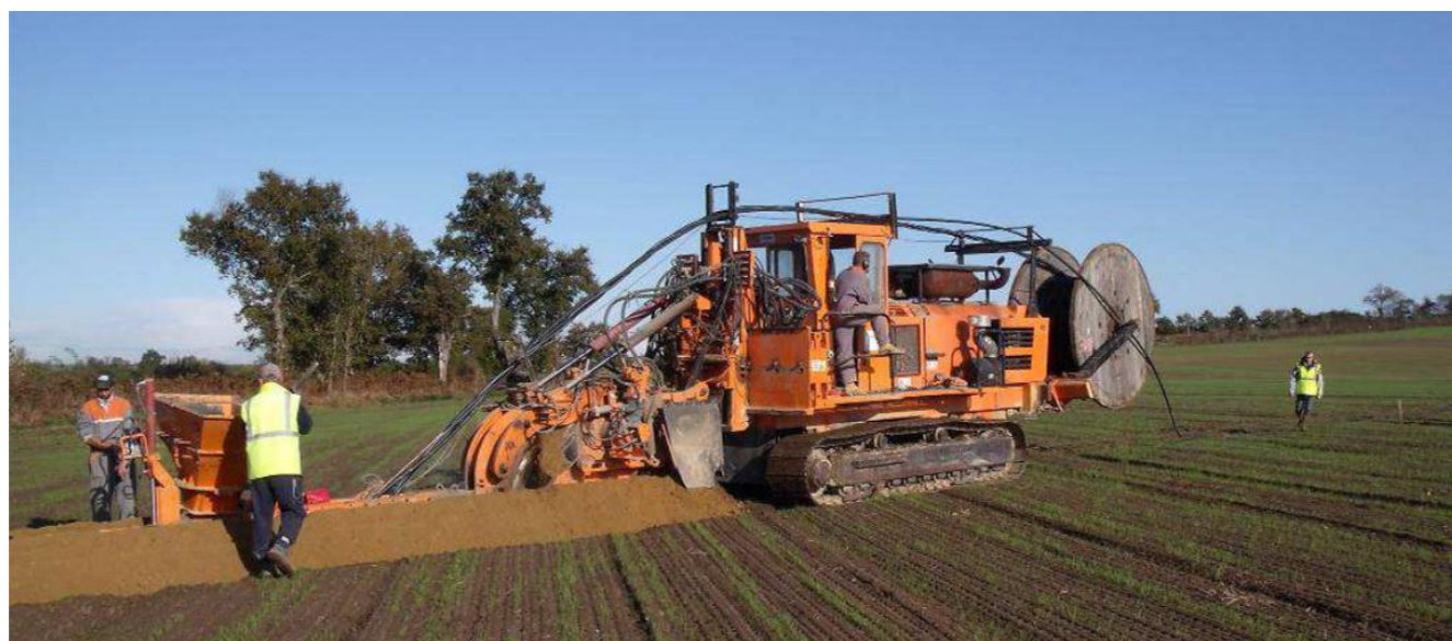
Photo 3 : Pose de câble par trancheuse sur une parcelle privée
