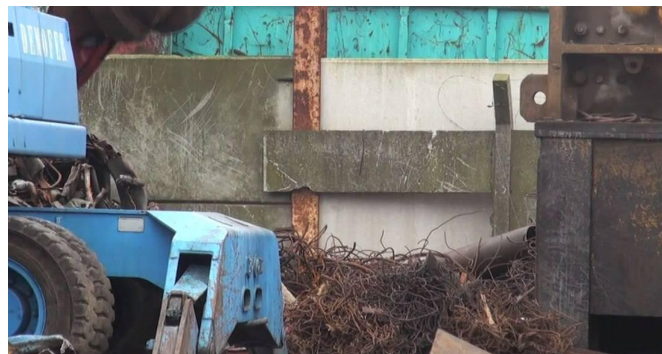
Photo 15: Evacuation des éléments démantelés (1)
